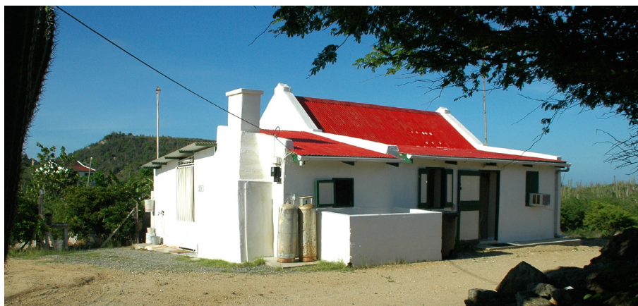
Figuur 10: Een voorbeeld van een zinken dak. Foto collectie Stichting Monumentenfonds Aruba.
